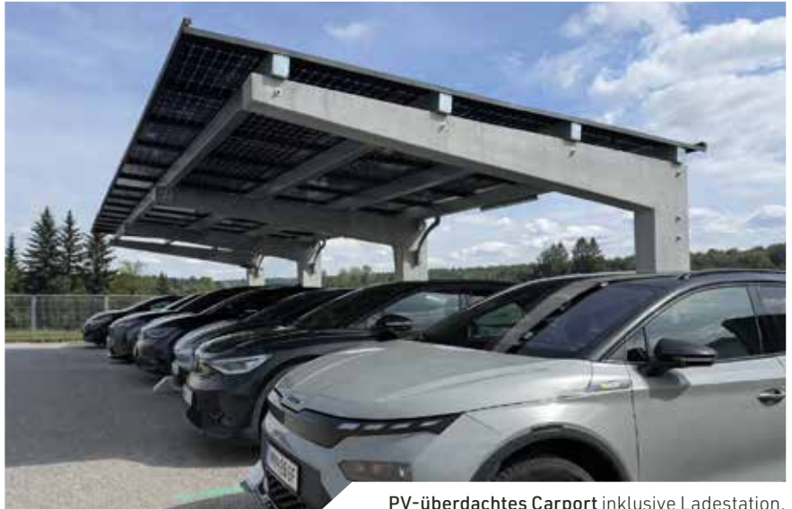
PV-überdachtes Carport inklusive Ladestation.
