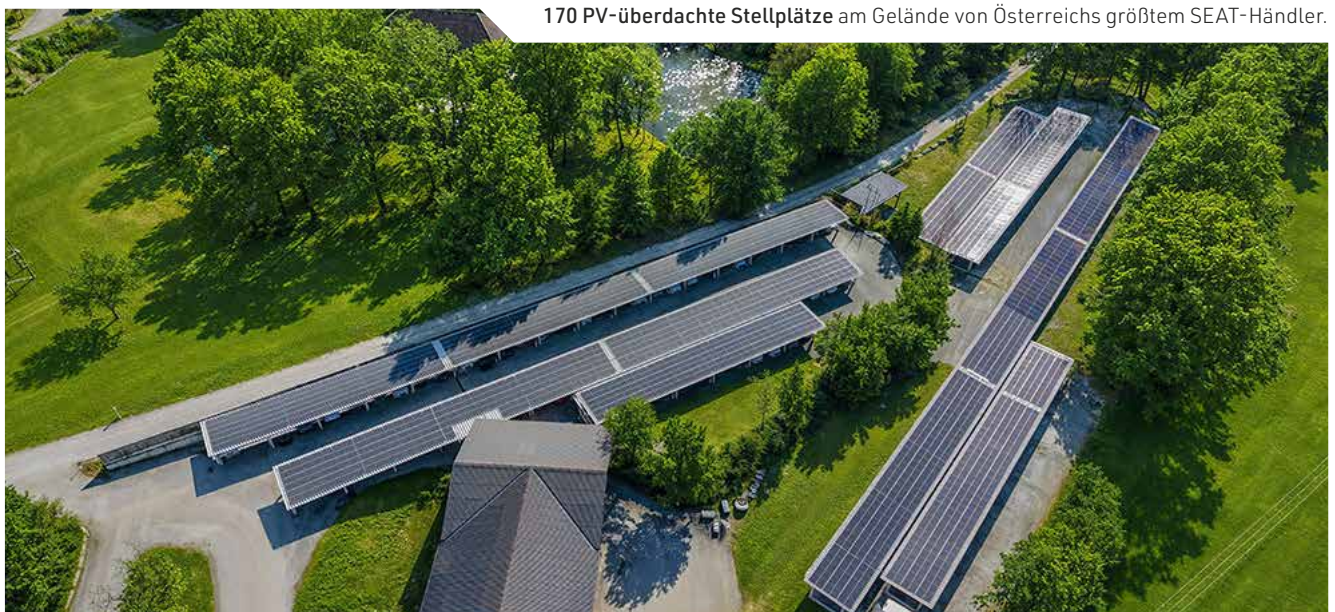
170 PV-überdachte Stellplätze am Gelände von Österreichs größtem SEAT-Händler.
