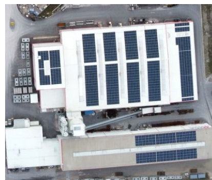
PV der MABA am Standort Wöllersdorf, © Kirchdorfer
