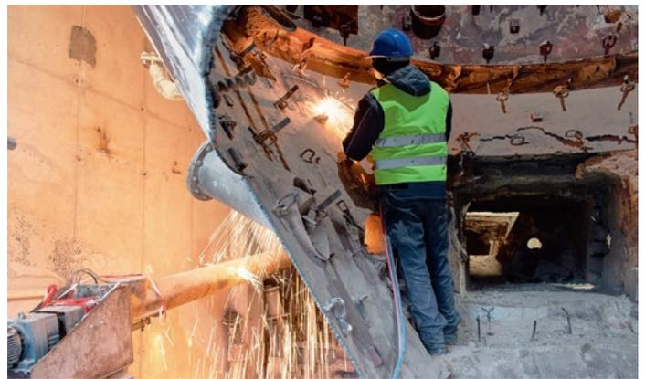
**Alternative Brennstoffversorgung rund um die Uhr:** Über einen Trogkettenförderer wird Brennstoff in die feuerfesten Rohrleitungen des Kalzinators gespeist.
