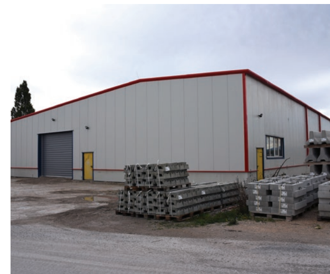
Das zentrale MABA Schalungslager in der neuen Halle 3 wurde bereits im Herbst 2019 in Betrieb genommen.
