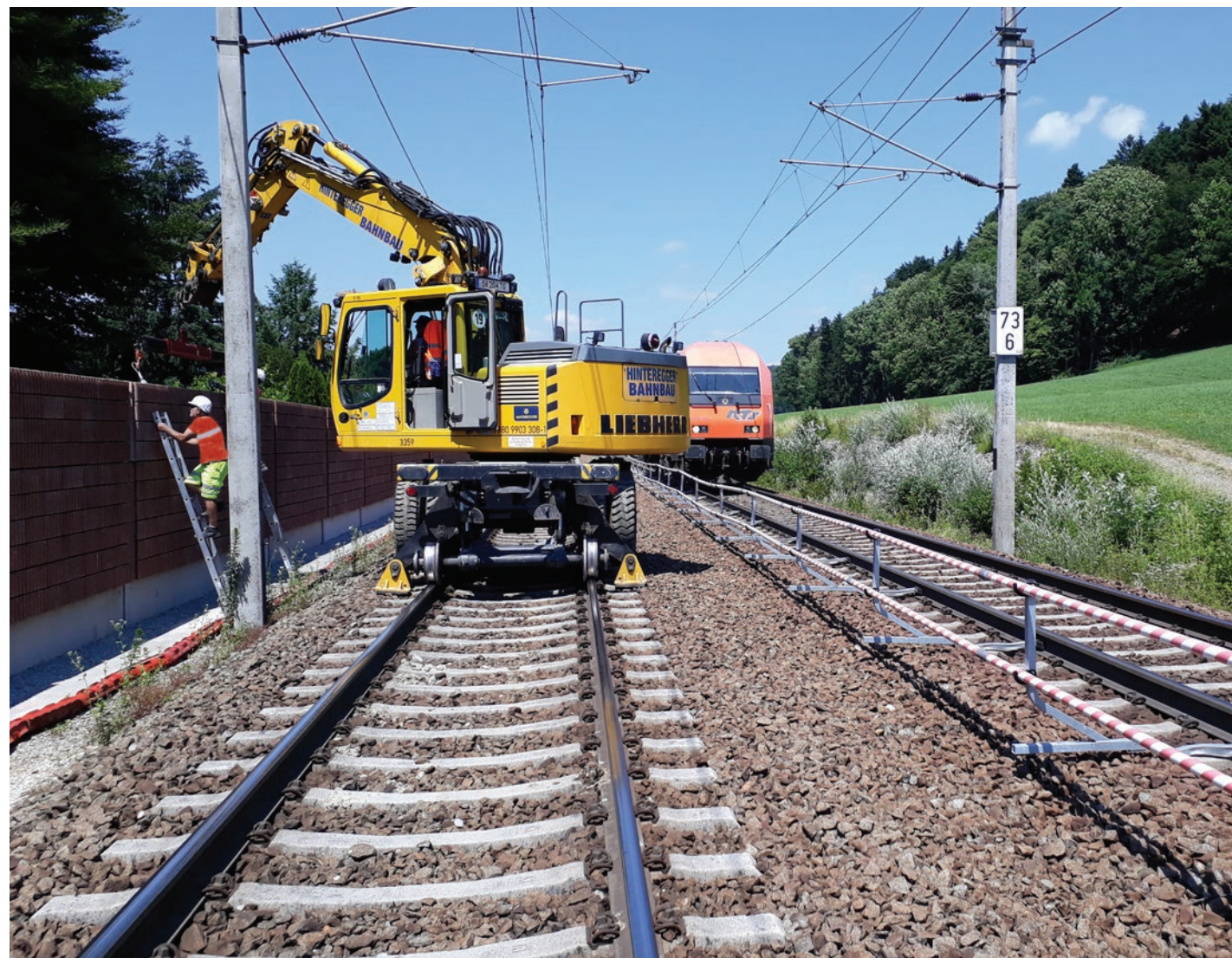
Das Versetzen der Lärmschutzwände im Bereich Bahnhof Wernstein konnte bei laufendem Bahnbetrieb durchgeführt werden.
