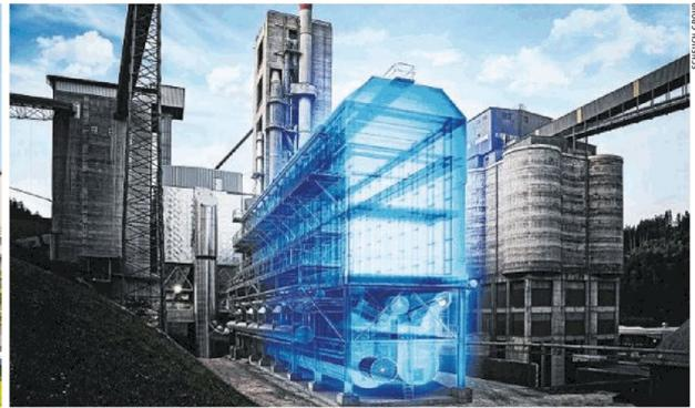
Das Kirchdorfer Zementwerk punktet nicht nur durch seine außergewöhnliche Optik. Rechts die innovative DeCONOX-Anlage, die den CO<sub>2</sub>-Ausstoß verringert und die Abwärme nutzbar macht
