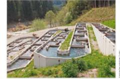
Durch die Reduktion von Durchflussmenge und Turbulenzen erhöht sich die Durchlässigkeit für den Aufstieg von Fischen bei gleichzeitig reduzierter Wasserhöhe.
