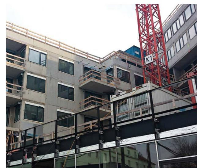
**Effizienter Wohnbau mit Halbfertigteilen:** Doppelwände und Elementdecken aus dem MABA-Standort Gerasdorf sorgen für raschen Baufortschritt.
