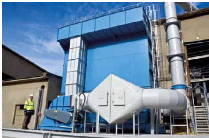
Die neue Filteranlage wurde in Einzelteilen geliefert, im Hof zusammengebaut, und mit einem Kran auf das Dach des Mühlengebäudes gehoben und dort installiert. Mitten im bitterkalten Winter, während das Zementwerk nur auf geringer Auslastung fuhr.
