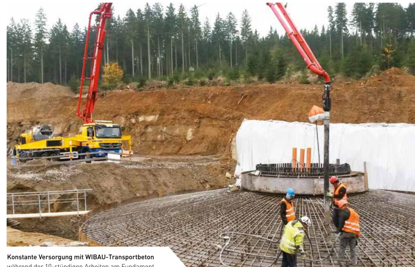
Konstante Versorgung mit WIBAU-Transportbeton während der 10-stündigen Arbeiten am Fundament für eines der beiden neuen Windräder.
